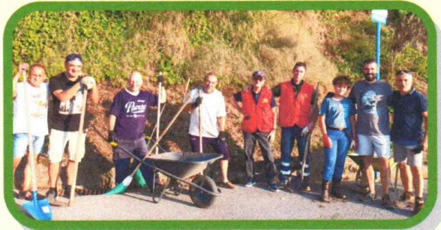
foto: Facciamo correre l'acqua, intervento di pulizia delle cunette da Alessia al confine di Santi Quaranta.
